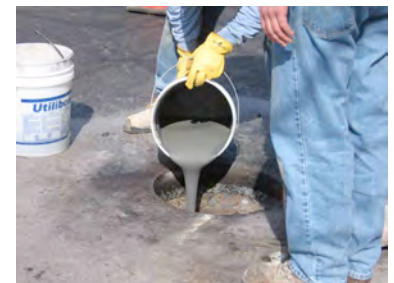
9. Pouring Utilibond in the hole
